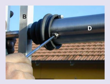
Serrare i sei grani di connessione fra il puntale (D) e il supporto rotante (B), cercando di mantenere un angolo di 90° fra i due. In seguito, i grani, saranno utilizzati per l'ultima regolazione di messa in bolla della parte rotante.
