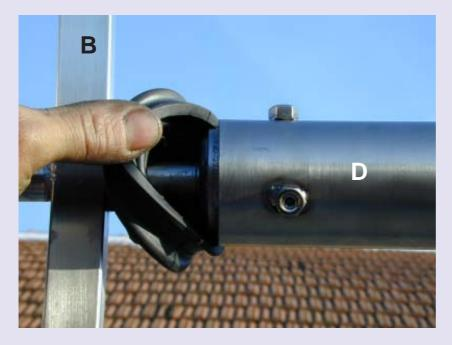
Infilare la base del supporto rotante all'interno del puntale, lasciare c.a. 30 mm. fra l'apice del puntale e l'asta della rotante, come in figura adiacente.
