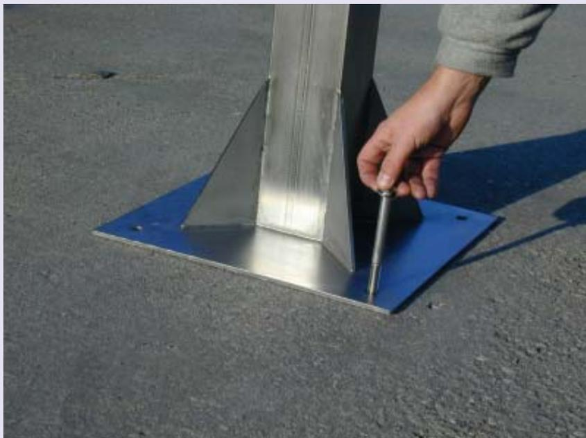
Fissare la piastra d'ancoraggio con n. 8 tasselli chimici di diametro 14 mm. (non compresi) ad un plinto in cemento di dimensioni: cm. 150 x 150 x 100 c.a. tre metri cubi. Nel caso necessiti si dovrà spessorare la piastra per mantenere verticale il tronco base (messa in bolla).
